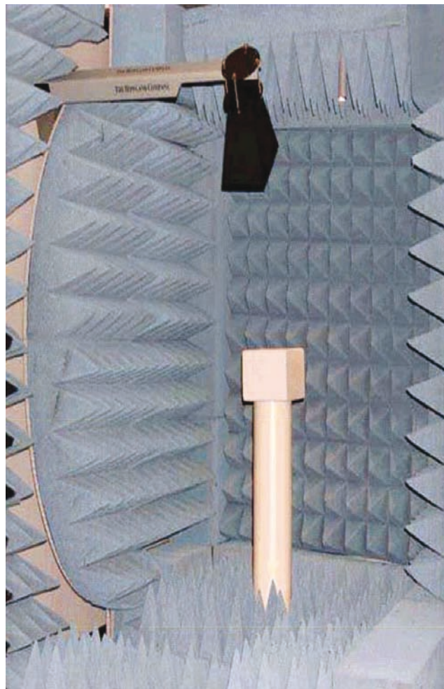
Fig.4 - Particolare della camera schermata
